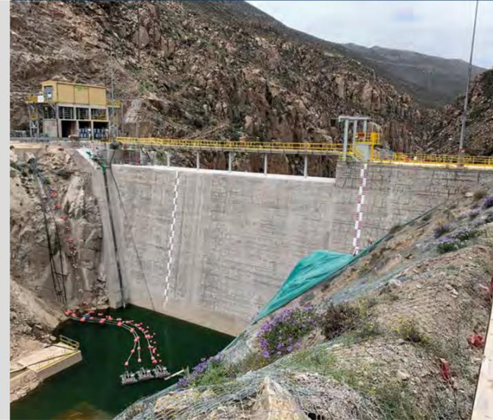
Construcción de una presa de Cemento Compactado con Rodillo, para el proyecto Quellaveco. Ayudará a evitar que el agua contactada por la operación minera llegue al río. Tiene una altura de 40 metros y una cresta de 70 metros.
