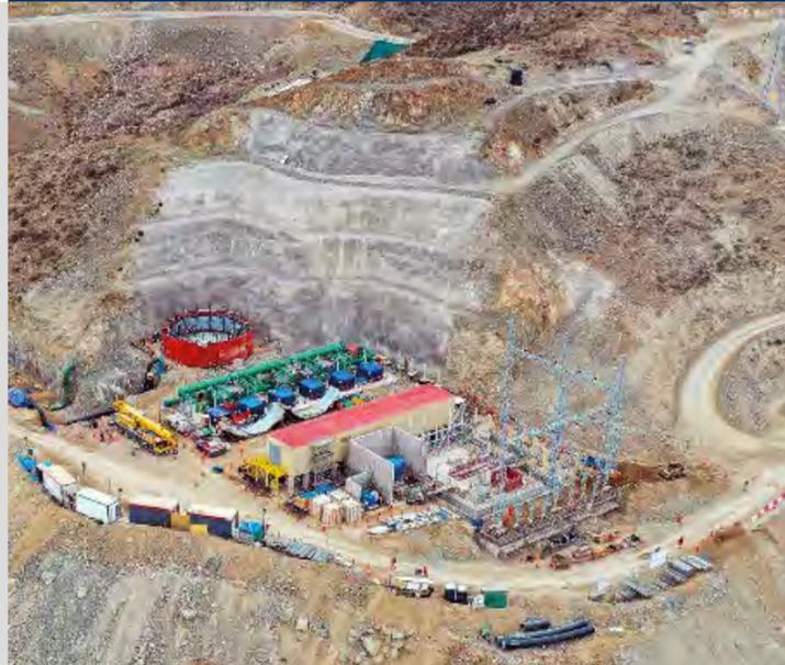
Conjunto de obras que permitirán transportar, distribuir y depositar los relaves de la mina Quellaveco. Comprende trabajos de movimiento de tierra, obras civiles, montaje electromecánico, piping, eléctrico e instrumentación de las partes que conforman el sistema.
