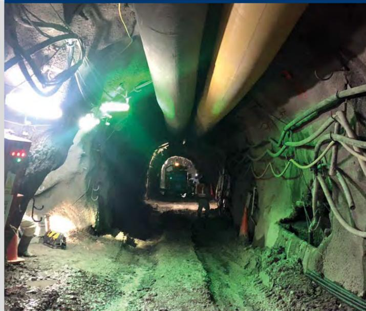
Ejecución en dos etapas: Etapa de excavación subterránea y etapa de obras de concreto. El túnel se conectará con la nueva estructura de decantación construida por Antamina para que por el recrecimiento del Depósito de Relaves no impacte con la estructura actual.
