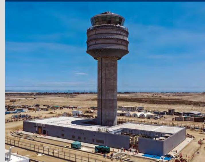
Con una altura de 65 metros, la nueva torre estará construida de concreto armado combinado con una estructura superior de acero.
