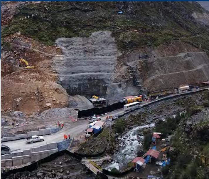
Construcción de una nueva poza colectora de filtraciones, estaciones de bombeo, sistemas de tuberías, subestaciones eléctricas, un nuevo camino, la extensión del túnel de decantación y el cierre de la poza de colección de filtraciones existente.
