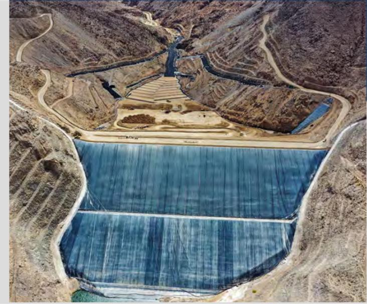
Construcción de una presa de relaves que filtra el agua para que pueda ser reutilizada en la operación de la mina Quellaveco. En paralelo se realizó la construcción del drenaje basal, y los caminos de accesos Lama Sur, Ciclones, 4001 y 4012.
