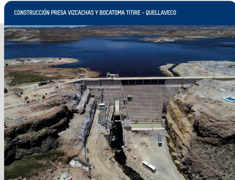
Construcción de la presa de tipo gravedad, hecha con concreto compactado con rodillo (CCR) y concreto convencional. Esta cuenta con un sistema de suministro de agua fresca a través del río Titire y el río Vizcachas para la operación del proyecto Quellaveco, que demandará alrededor de 770 litros por segundo.
