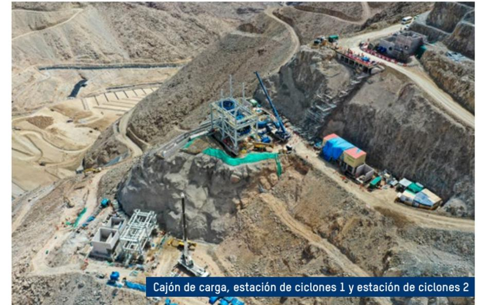
Cajón de carga, estación de ciclones 1 y estación de ciclones 2
